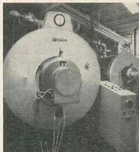
peinture; chambre de combustion alimentée en air et en combustible par un groupe d'alimentation comprenant un ventilateur centrifuge, une pompe à engrainages entraînés par des moteurs électriques différents; armoire de régulation contrôlant la marche automatique de la chaudière, comprenant comme éléments essentiels: 1 programmateur, 1 détecteur de flamme, 1 détecteur de niveau d'eau, systèmes de sécurité.
